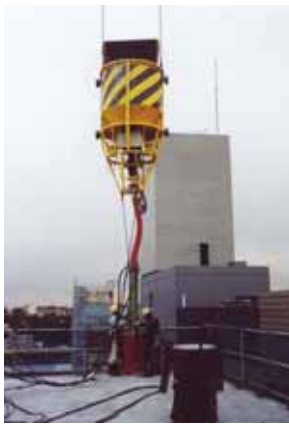
写真 4-3 落とし込み充填工法の例
