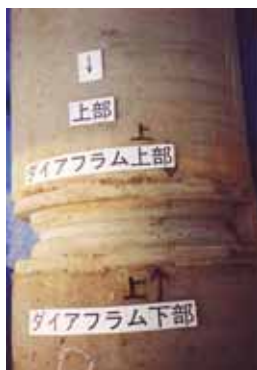
写真 4-5 円形断面の例 (環状ダイアフラム断面)
