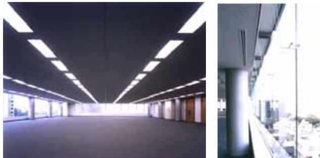
写真.3-2 無耐火被覆工法の建物例
