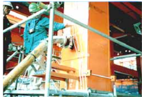
写真 4-4 圧入工法の例
