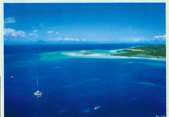
アース・ポート全景 (左側が海上の主要施設、右側が陸上のサポート施設)
