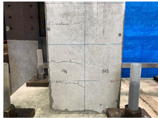
(d) R=5.0 \times 10^{-3} rad 左柱ひび割れ状況
