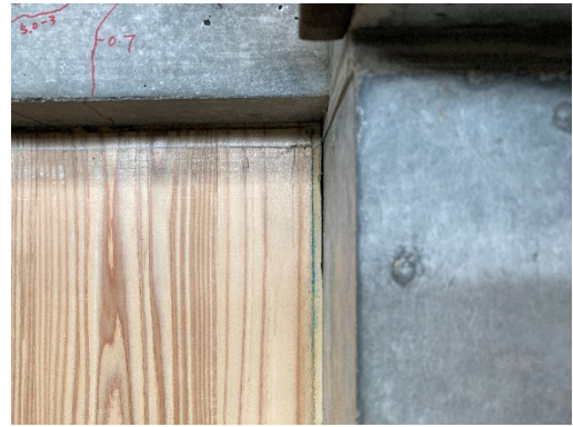
(f) R=10 \times 10^{-3} rad CLT と RC 柱の隙間
