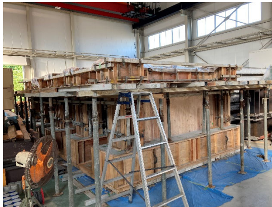
d. 柱梁打設後養生状況
