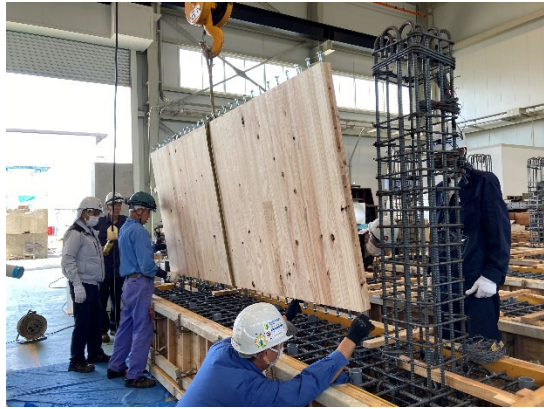
a. A2-LB CLT 耐震壁建込
