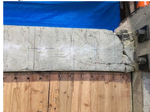
(l) R=50 \times 10^{-3} rad 梁部・DP 接合部損傷状況
