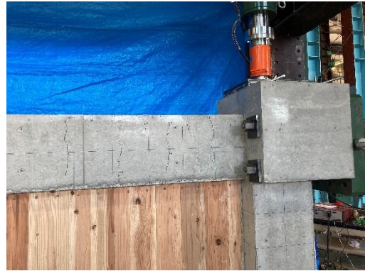
(b) R=2.5 \times 10^{-3} \text{rad} 梁右ひび割れ状況
